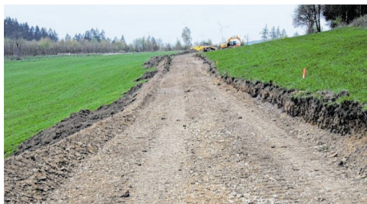
Breite Wege werden für den Bau der Windräder derzeit von der Kreisstraße 18 aus angelegt. FOTO: PRIVAT
