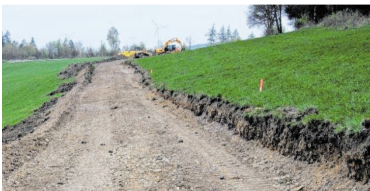
Derzeit ruhen die Arbeiten an der Zuwegung und den geplanten Standorten der Windräder.
