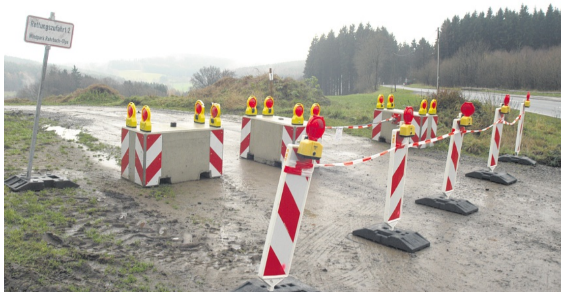
Mit schweren Betonblöcken hat der Kreis Olpe die Baustraße zum Windpark bei Rahrbach blockiert und damit die Baustelle lahm gelegt. Jetzt haben wieder die Richter das Sagen.
