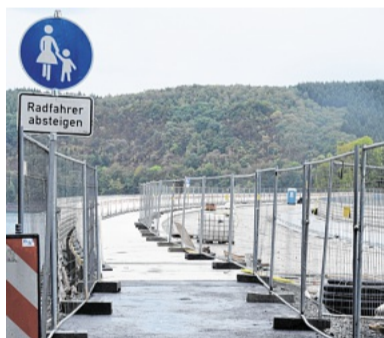
L 563: Baustelle Talbrücke Kessenhammer. FOTO: JANA WEHMMANN
