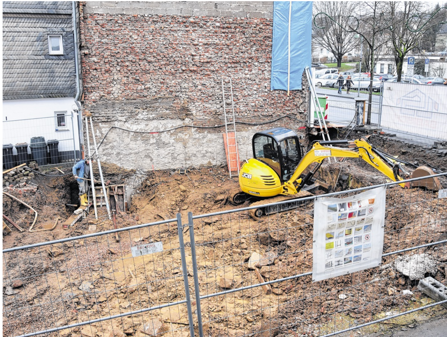
Baustelle Martinstraße 5 in Olpe: Baufirmen, die sich mit dem Aufspüren alter Sprengmittel aus dem 2. Weltkrieg auskennen, sind derzeit häufiger Gast. Mit im „Boot“ der Kampfmittelbeseitigungsdienst der Bezirksregierung.
