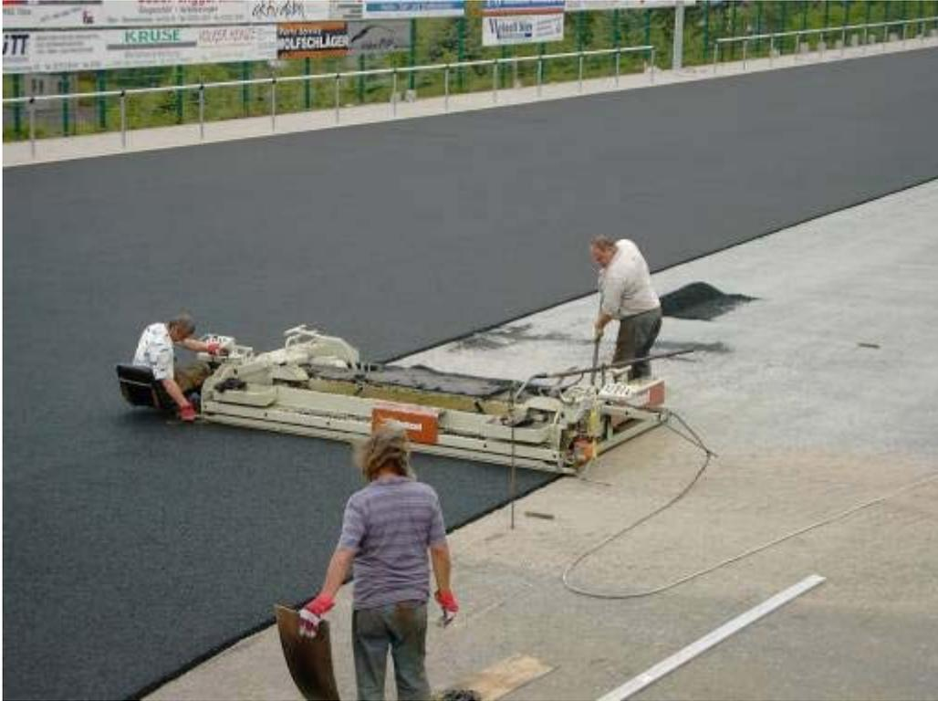
**1. Juni 2004:** Die elastische Tragschicht, ein Gemisch aus Splitt, Gummi und Kleber, wird aufgebracht.
