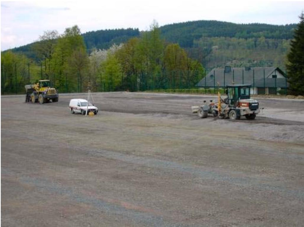
**3. Mai 2004:** Die Schotterschicht wird aufgetragen. Die Nivellierung erfolgt mit elektronischer Unterstützung.
